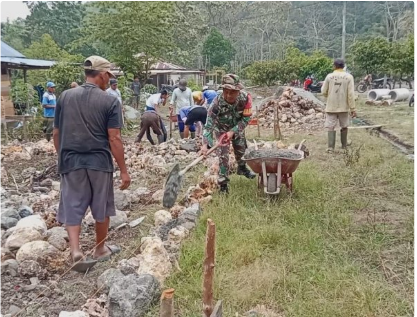
Gotong royong bangun pondasi rumah warga
